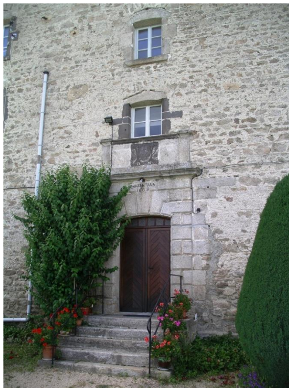
Fig. 2 : l'Hermitage : portail du XVII e s sur la façade reconstruite au XVIII e .
