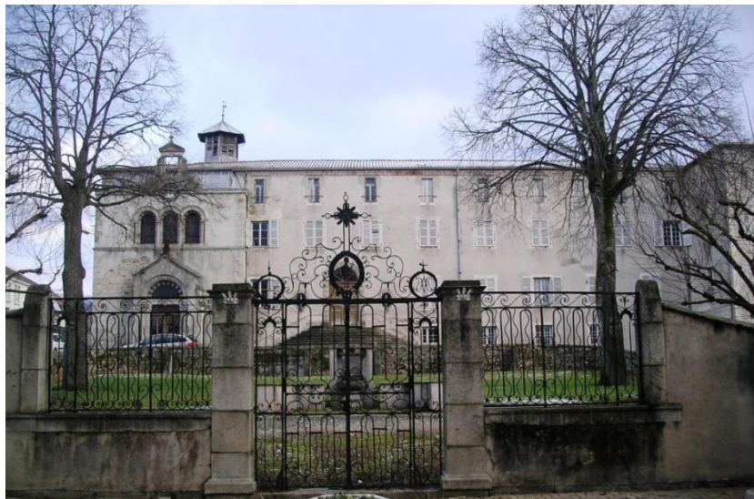
Fig. 3 : l'Hôpital d'Ambert, état actuel. La chapelle se trouve à gauche.
